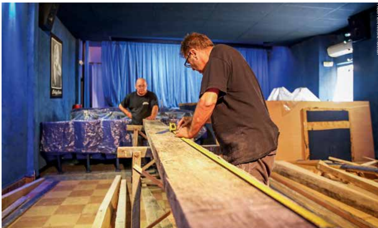
Découpe du nouveaux plancher - services techniques.
