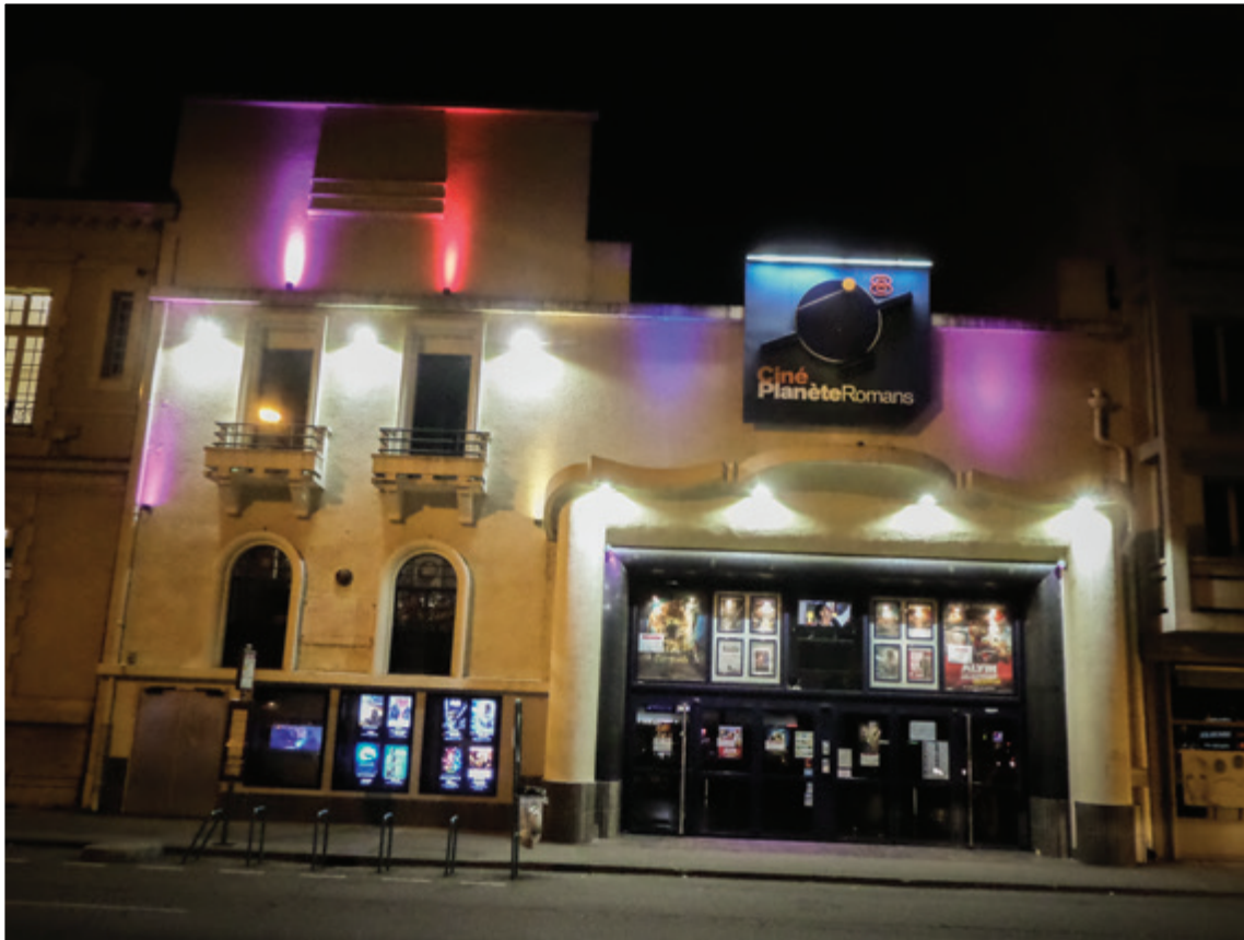
Facade extérieure (en attendant une rénovation)
